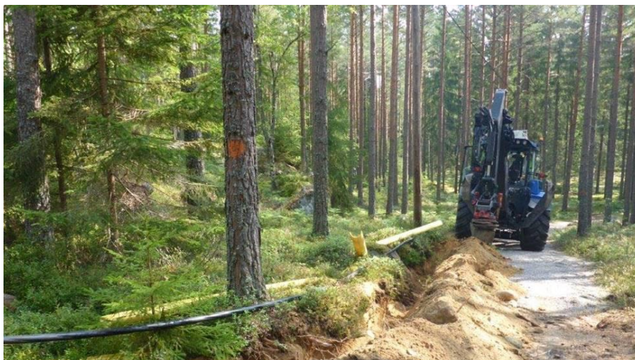
Grävarbeten och markförläggning av ny el-matning
