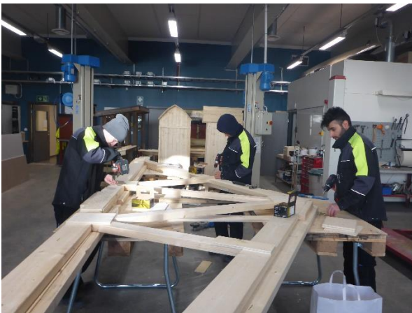
takstolarna vid Bergska skolan
