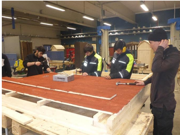
Prefabricering av väggelement och
