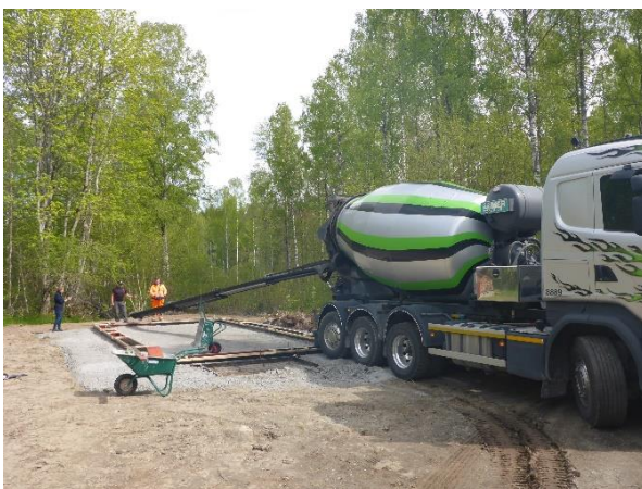
Rännan för cementen räckte precis fram vid gjutningen.
