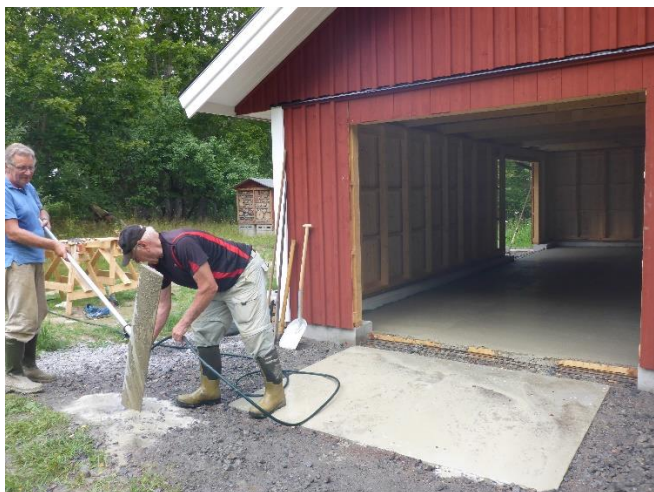
Nils-Åke Nilsson och Jens Rinman rengör "slodan" efter utjämning av golvets 4 kubikmeter betong den 14 augusti
