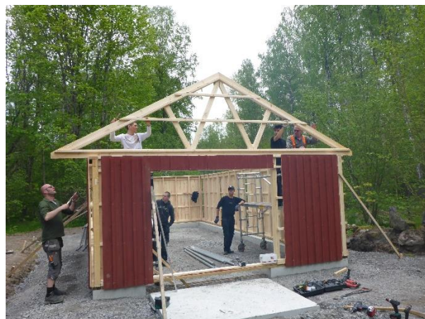
Montering av väggsektioner och takstolar
