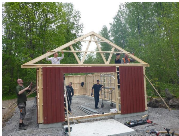
Montering av väggsektioner och takstolar
