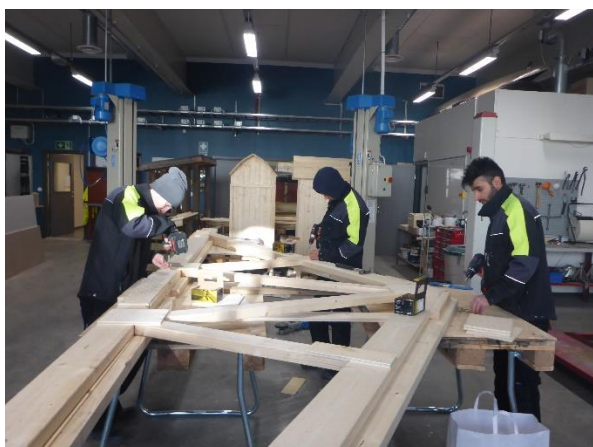
takstolarna vid Bergska skolan
