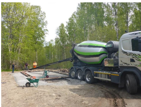
Rännan för cementen räckte precis fram vid gjutningen.
