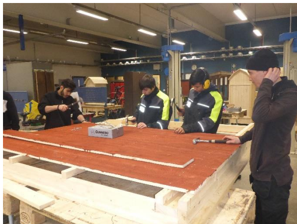
Prefabricering av väggelement och
