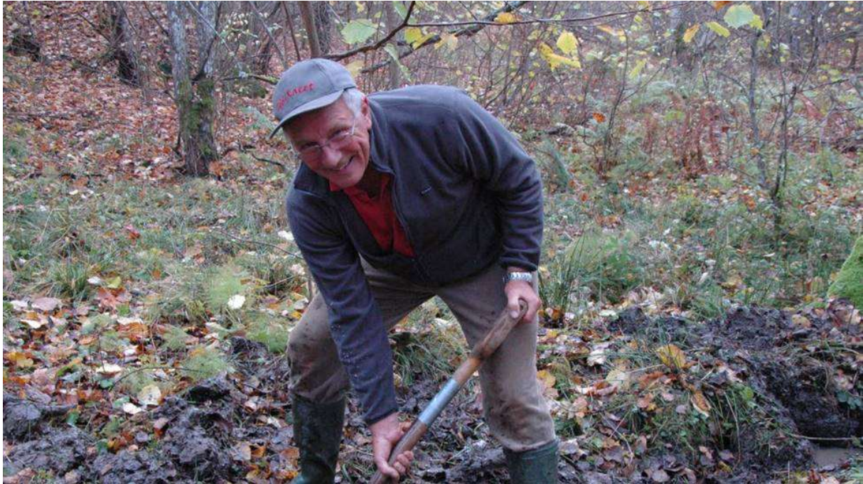
BILD: Magnus Johansson | Gräver. Ordförande Jens Rinman i grävtagen med dräneringsarbete i Luddalen.
