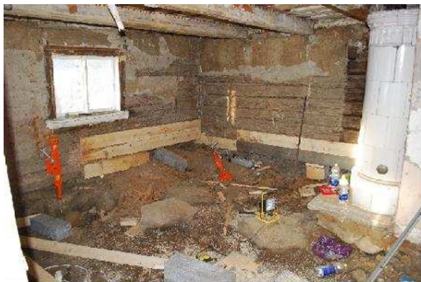
Renovering pågår i storstugan – januari 2011
