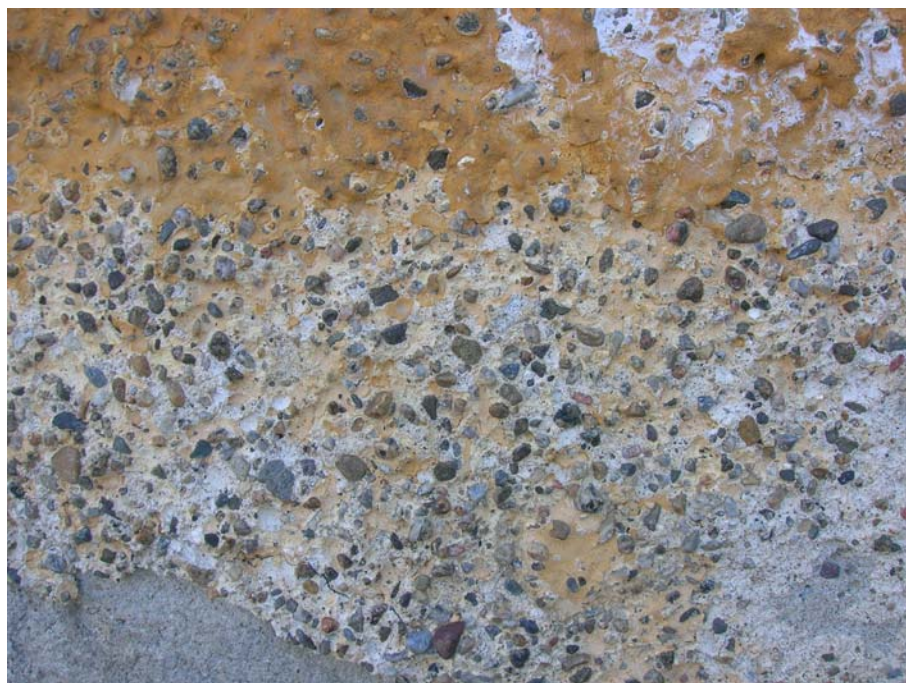
2009-06-24. Förvaltningsbyggnaden 002. Putsskada vid entrén med sannolikt platsblandad spritputs.
