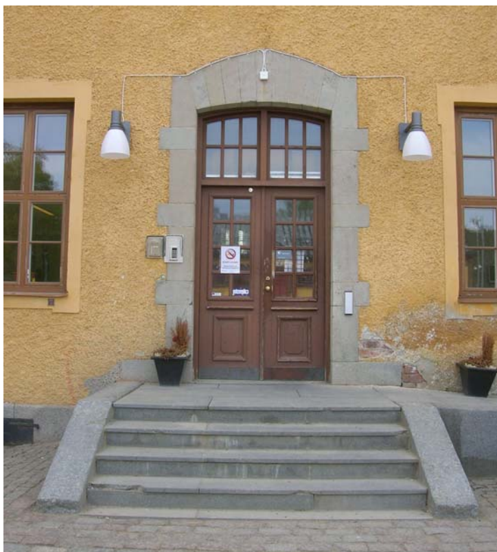
2009-05-18. Förvaltningsbyggnaden med nya armaturer som flankerar porten enligt ritning. (Senare inmålade el-dosa och ledning, putsskador, se sid. 20).
