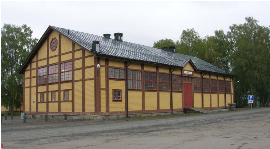
Fd. Exercishuset, (byggnad 017), foto 2008-09-02.
