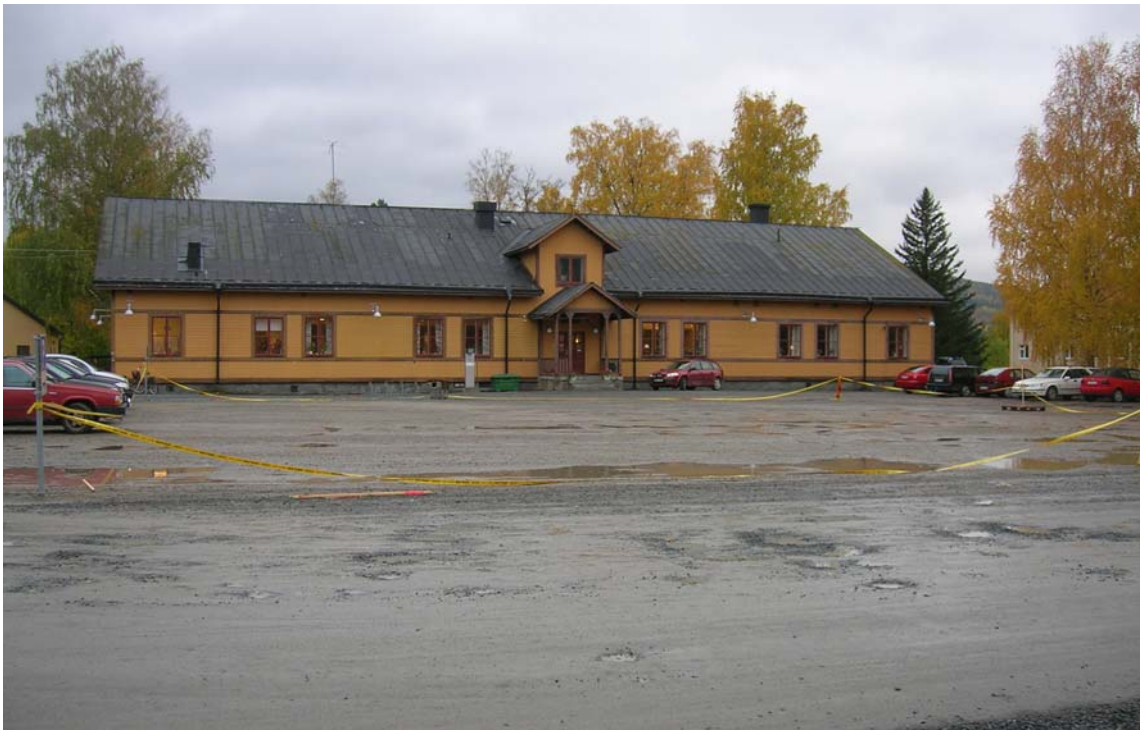
Byggnad 8, Beväringkasernen. Foto 2008-09-02.
