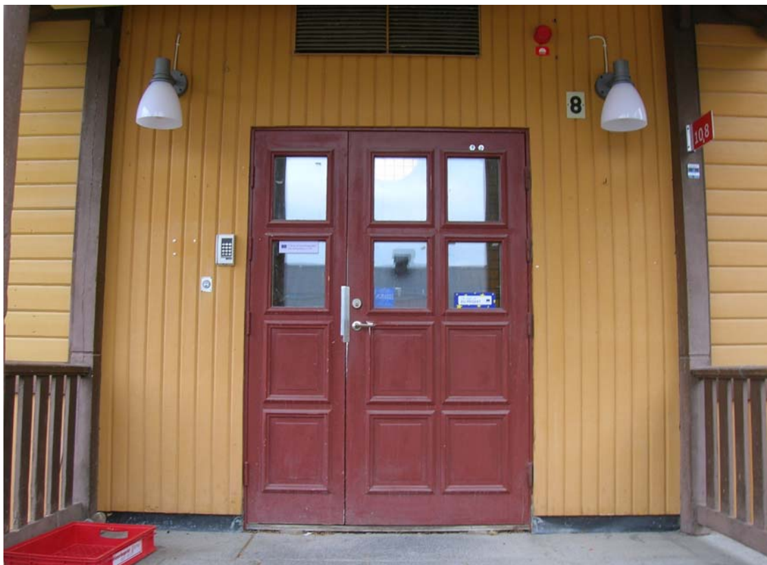
2008-09-02. Byggnad 8 efter byte till nya armaturer, Klippan 230.
