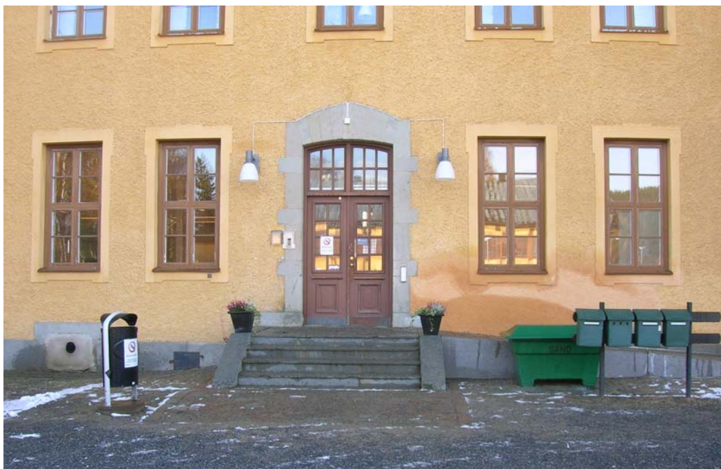
2009-10.20. Förvaltningsbyggnaden 002 efter avfärgning.
