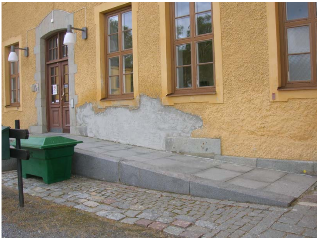
2009-08-25. Fasaden med påslag av Porosan.
