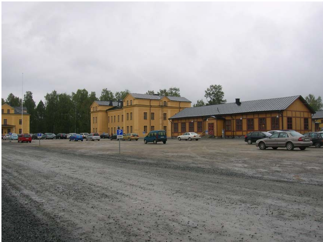
2008-09-02. Södra sidan av kaserngården. Närmast byggnad 4. Efter montering av nya armaturer.
