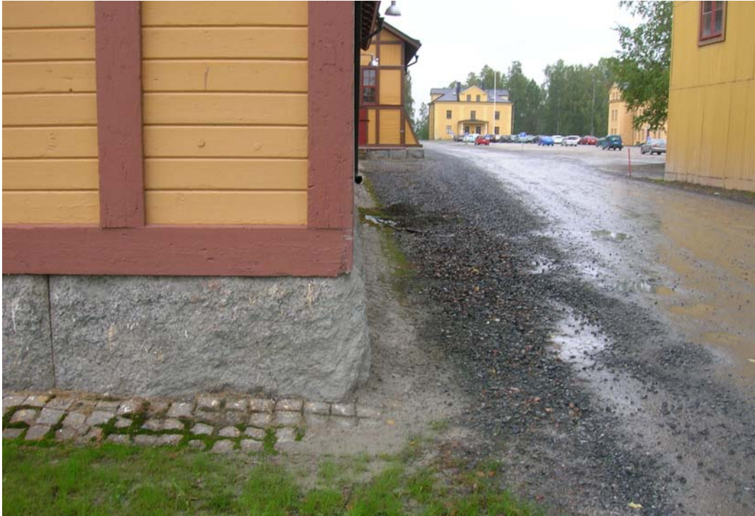
Infarten från väster till kaserngården, foto 2008-09-02 (Förrådsbyggnad 010, kortfasaden, till höger).
