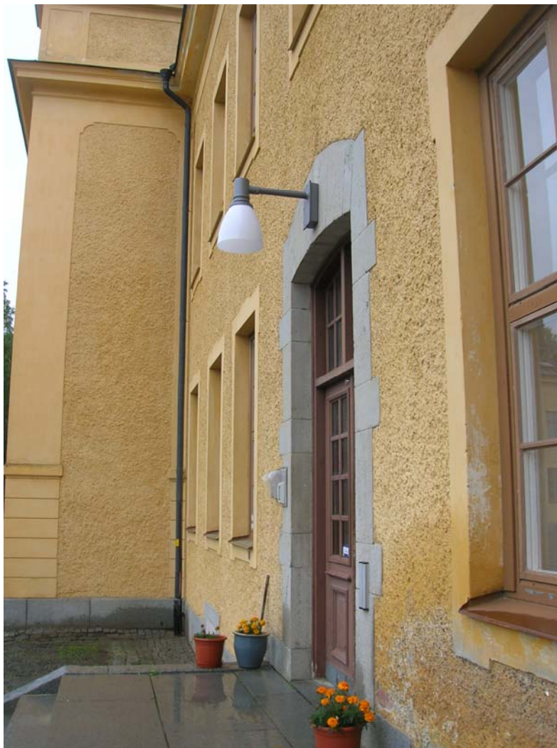
2008-09-02. Förvaltningsbyggnaden före ändrad placering av armaturer.
