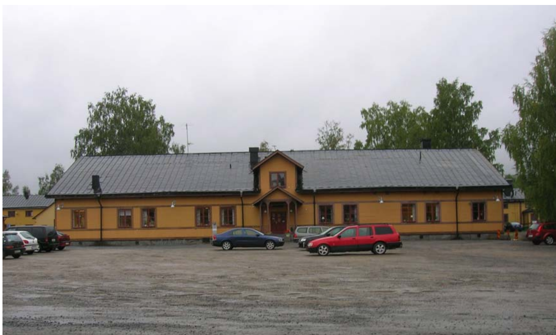
2008-09-02. Byggnad 008 med nya lyktor "Solo vägg".
