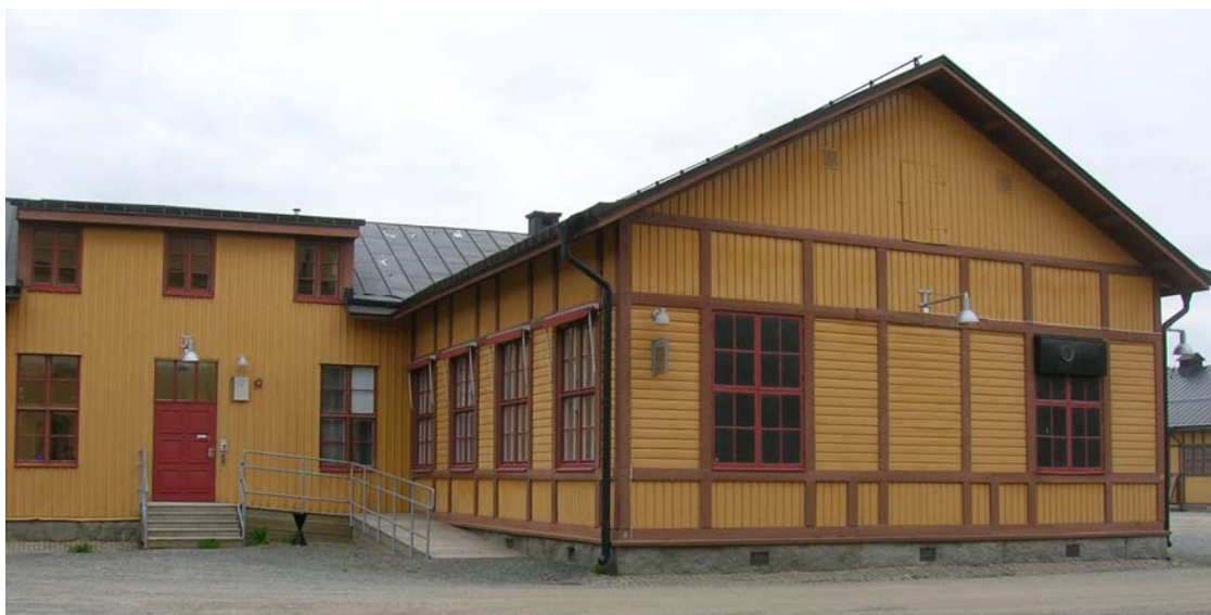
2008-09-15. Byggnad 004 med armaturer mitt på gaveln och på NO hörnet, vilka senare har borttagits enligt handling. (Små skyltar osv. finns monterade på husen sedan tidigare).
