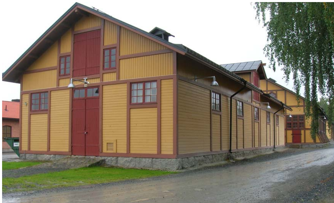
2008-09-02. Byggnad 014-015 med nya lyktor "Solo vägg", vars placering senare ändrades.
